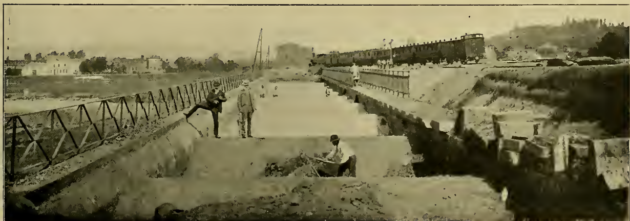
UNE VUE DES CHANTIERS DES TRAVAUX DE L'OURTHE.
