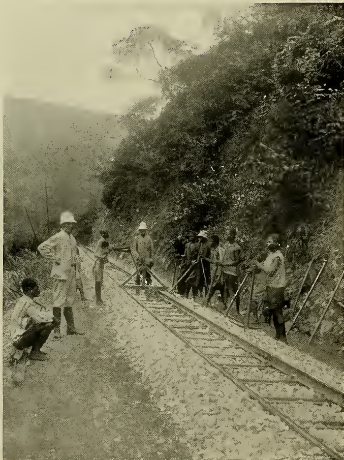
Ouvriers travaillant à la voie. — Chemin de fer du Bas-Congo.
