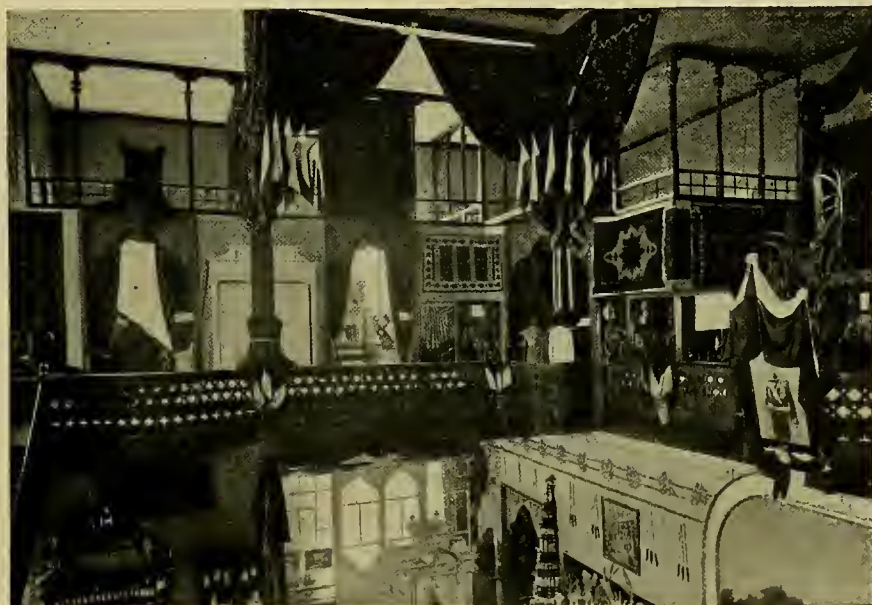
UN ASPECT DU PREMIER ÉTAGE DU PAVILLON.
