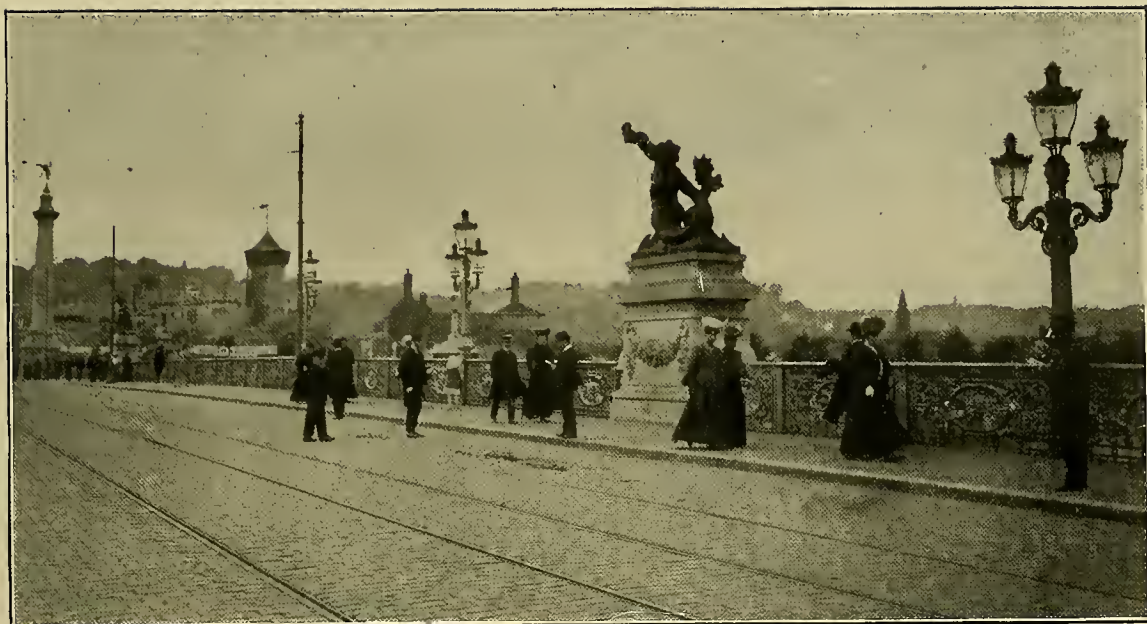
L'EXPOSITION VUE DU PONT DE FRAGNÉE.
