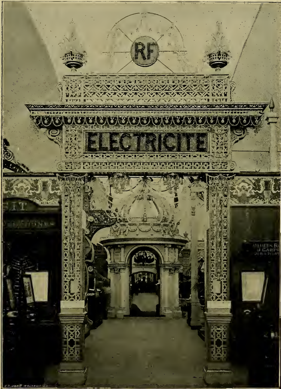
PORTIQUE DE L'ENTRÉE DU COMPARTIMENT DE L'ÉLECTRICITÉ.
