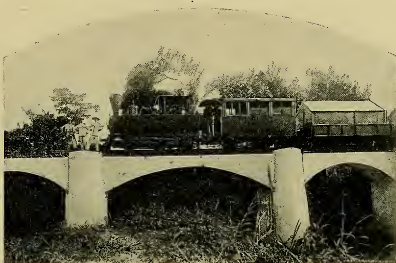
Un train sur le Pont de la Luki. — Chemin de fer du Mayumbé.
