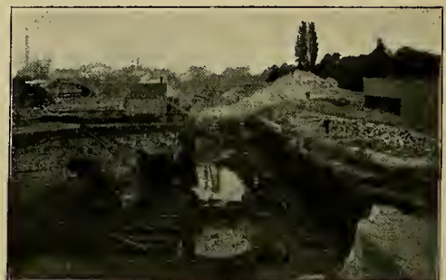
Travaux de la rectification de l'Ourthe.
