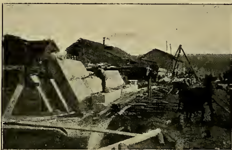
Construction de la pile droite du pont de Fragnée.
