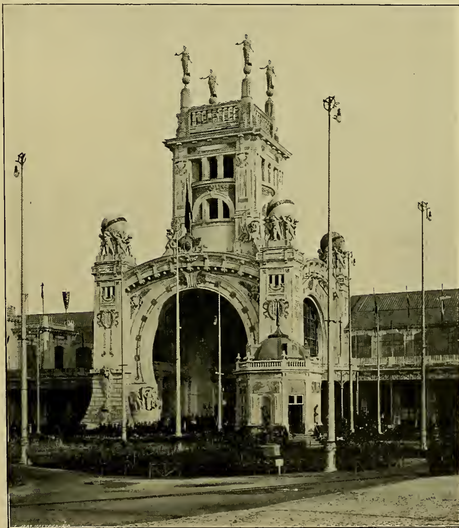
LE PORTIQUE CENTRAL DE LA FAÇADE PRINCIPALE DES HALLS.
