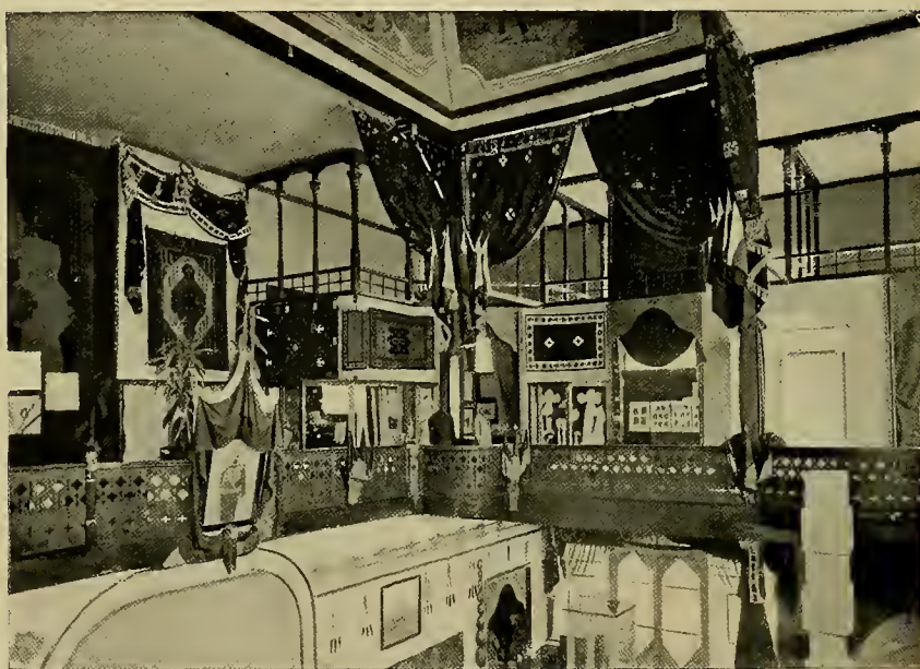
UN ASPECT DU PREMIER ÉTAGE DU PAVILLON.
