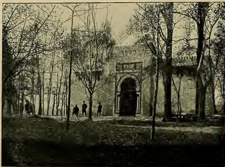
Pavillon de la Tunisie. -- Entrée principale.
