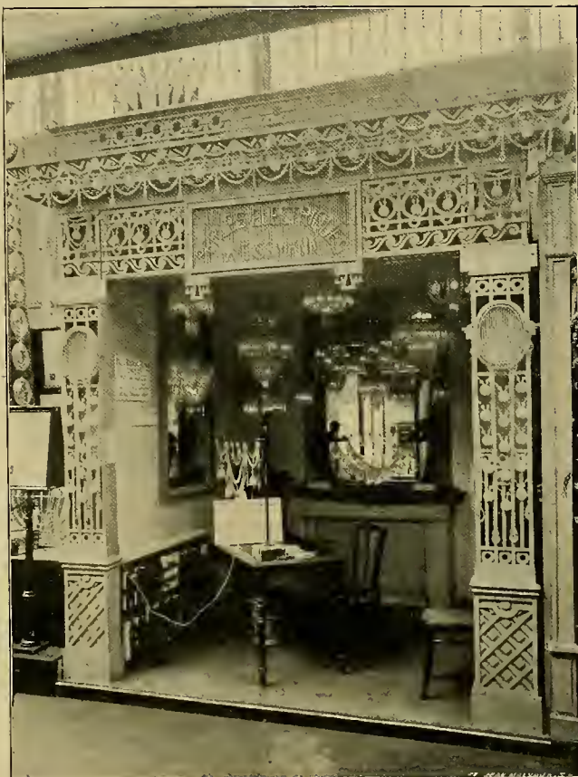
Un Stand de l'Electricité.
