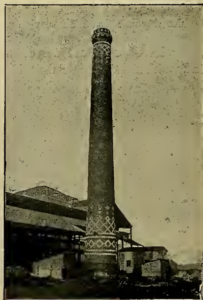
La cheminée de 40 mètres de hauteur.
