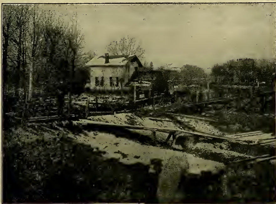
UN COIN DE FÉTINNE, AU DÉBUT DES TRAVAUX, EN 1903.
