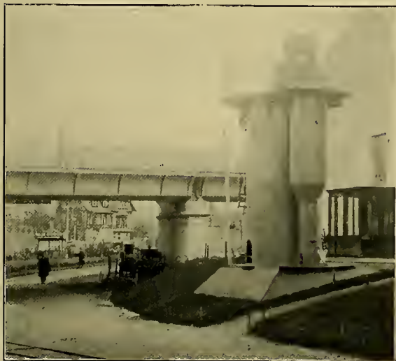
Sous la voie ferrée du Nord-Belge.
