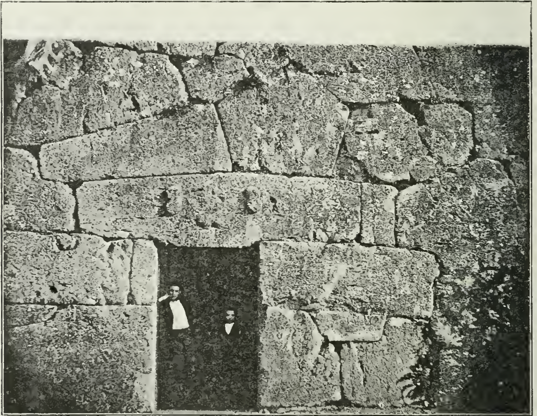
1783 Teil der Burgmauer von Matri mit Thorgang.
