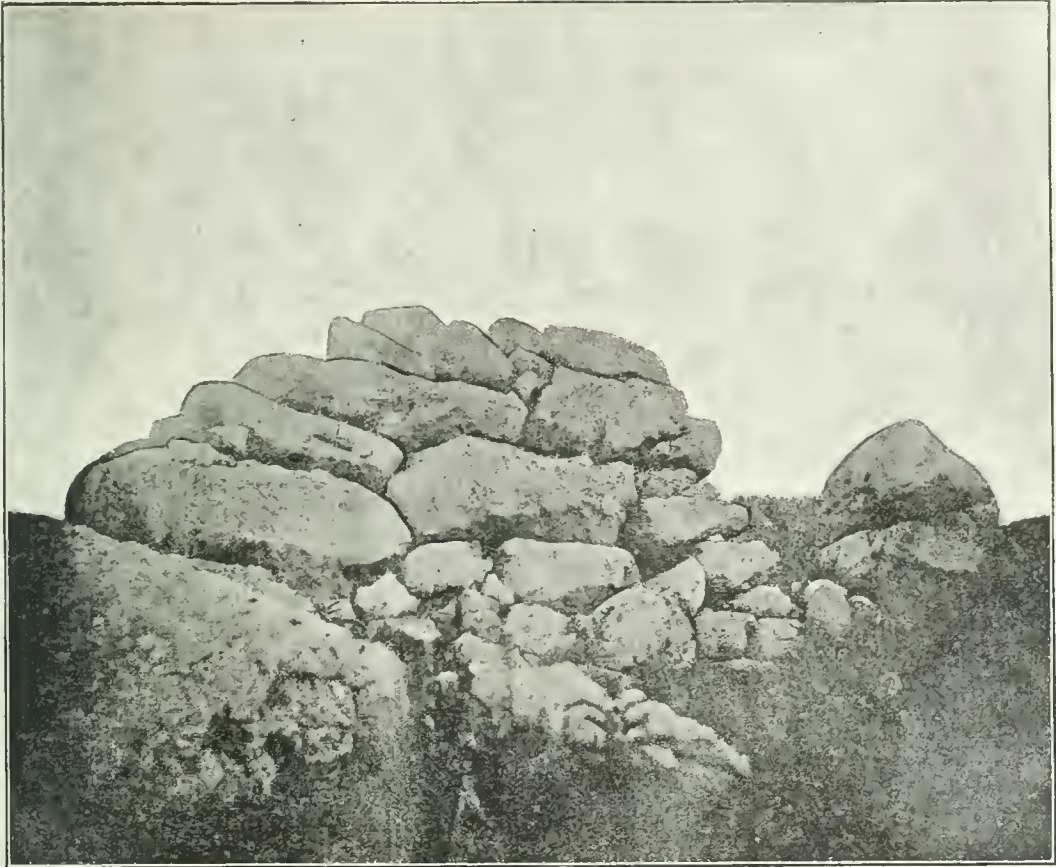
1779 Kyklopische Mauer von Numistrone in der Basilicata.
