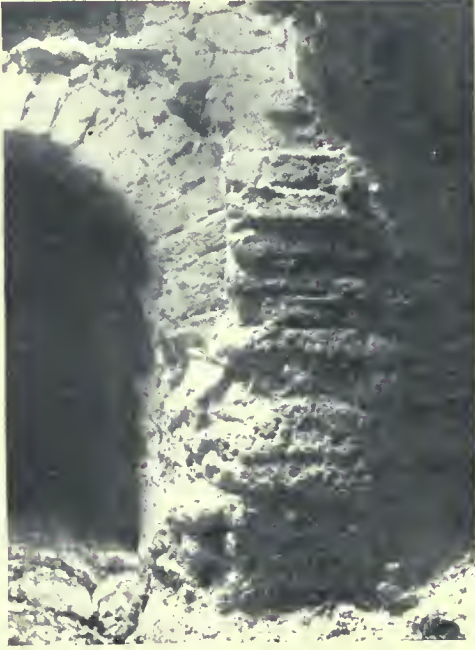
38: Mittelpfeiler, links nordwestliche Heizkammer.
