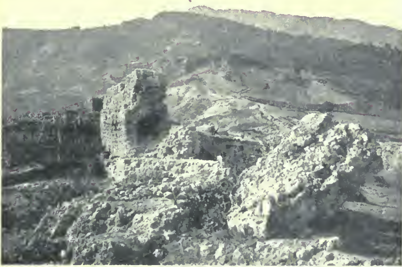
23: Spater Aquadukt, von Norden gesehen.
