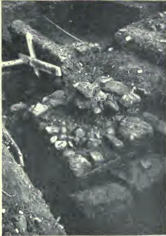
40: Brennraum mit Vorlagerung.
